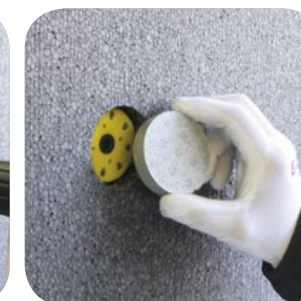
4. Talerzyk zagłębia się w izolacji na odpowiedniej głębokości, otwór zatykamy zaślepką. Gotowe!
