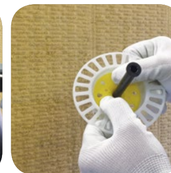
2. Osadź kołek wraz z dodatkowym talerzykiem VT 2G, który zagłębi się w izolacji.
