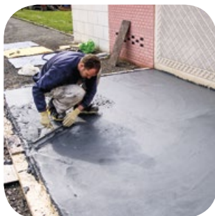
Jastrychy cementowe, w tym błyskawiczne
